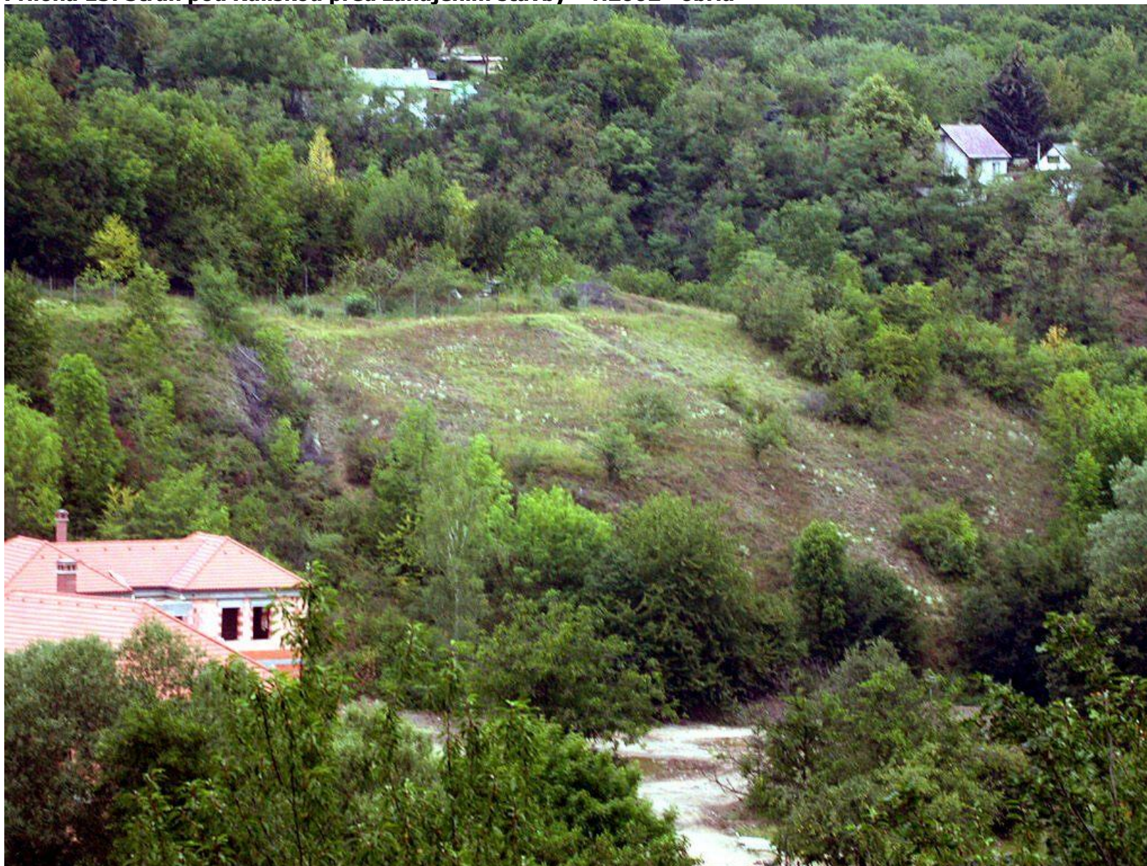
Příloha 13: Stráň pod Kuliškou před zahájením stavby – r.2002– obr.a
